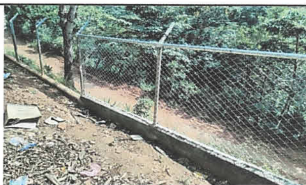
Foto 6: También se colocó tubo para cerca de 1 1/2" en sentido horizontal en la parte posterior junto a la fundición que tensa la malla hacia la pared del piso
