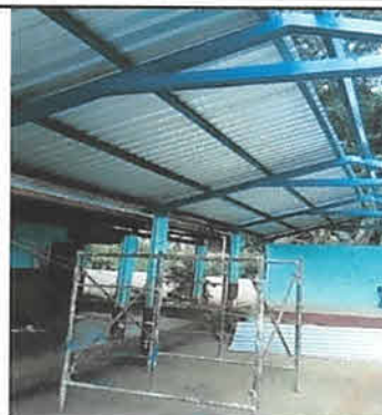
Foto 2: La lámina que se utilizó para la instalación de la cubierta es estilo troquelada calibre 26.
