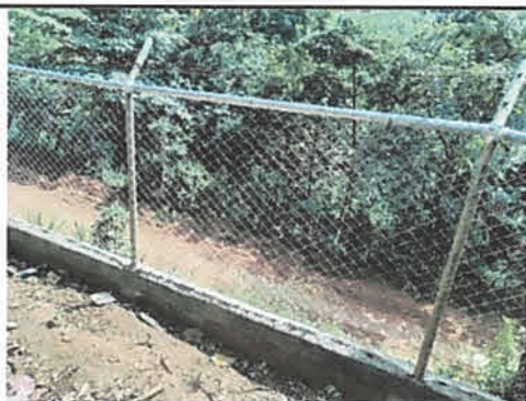
Foto 5: Las secciones de malla que se encontraban rotas fueron reemplazadas por malla nueva
