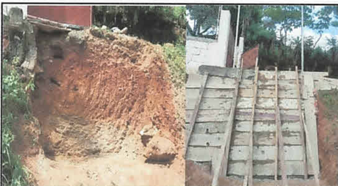
Foto 3: Se dio inició a la excavación realizando un corte en el terreno y se colocó formaleta de madera donde se fundirá el muro de contención con concreto ciclopeo
