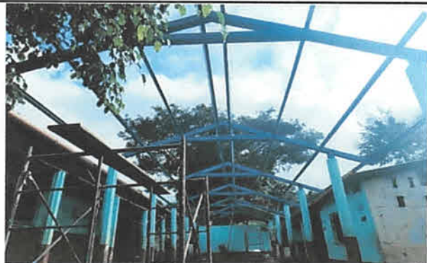
Foto 1: Se colocó estructura con tijeras construidas de costanera de metal de 4" x 2" dobles y cargaláminas de costanera de 4" x 2"
