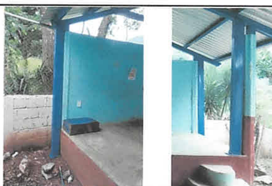
Foto 4: Se realizó el cambio el renglón de fundición de piso para colocar reforzamiento a las columnas de concreto con columnas de 6" x 4" con la finalidad de brindar mayor seguridad a la estructura
